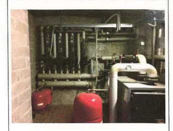
Riscaldamento con radiatori privi di valvole termostatiche e ventilconvettori in palestra
