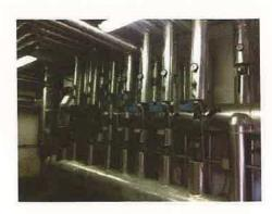
Preparazione dell'acqua calda sanitaria mediante bollitori elettrici installati direttamente nei servizi e due bollitori da 1000 litri ciascuno (Sile Bim 1000) in centrale termica.
