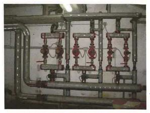
Produzione acqua calda sanitaria con circuito dedicato in centrale termica e con bollitori elettrici installati direttamente nei servizi igienici
