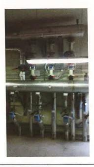
Preparatore acqua calda sanitaria Marca Sile, capacità 600 litri. Circuito di ricircolo sanitario.
