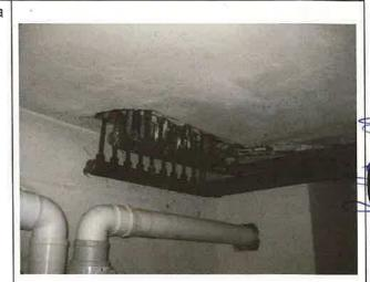
Impianto di riscaldamento con radiatori privi di valvole termostatiche
