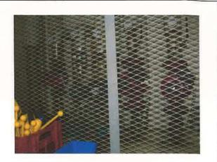
Preparazione dell'acqua calda sanitaria mediante bollitori elettrici installati direttamente nei servizi e bollitore da 1000 litri.
