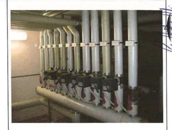
Riscaldamento con radiatori privi di valvole termostatiche e ventilconvettori in palestra
