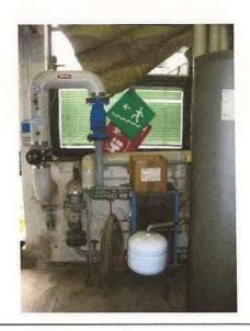
Collettore radiante con tre circuiti miscelati (uno per piano), il circolatore del piano secondo è stato recentemente sostituito.
