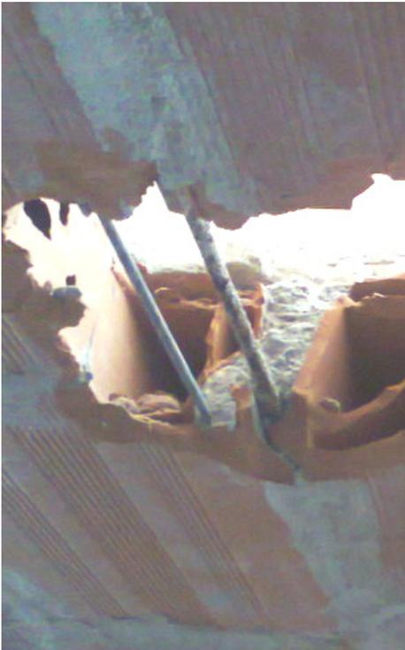
I travetti CIREX, di facile confezione, possono essere posti in opera affiancati, ottenendo l'interasse di cm 25, oppure distanziati a mezzo di blocchi interposti, ottenendo l'interasse di cm 55. Il solaio viene fornito nelle altezze di cm 12,5 - 16,5 - 20,5.
